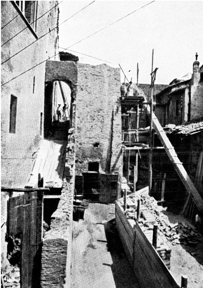
Ricostruzione scalone e disimpegno tra la Sala dell'Arengo e l'ex Albergo Corona
